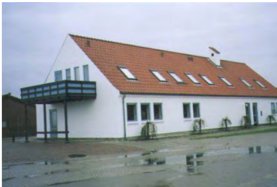
I forbindelse med nedlæggelsen af Sundets Marinedistrikt oprettes et Marinedistriktselement på Flådestation Korsør. Marinedistriktselementet placeres i Vognmandsrutens gamle billetbygning.
