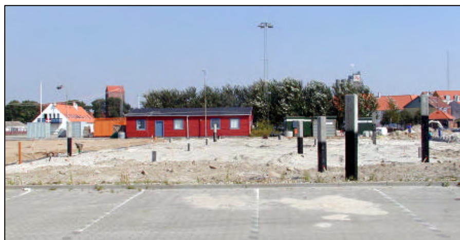
For at bygningen kan blive stående uden sætninger, skal den funderes på betonpæle. Det var her, det gamle orlogshjem lå.
