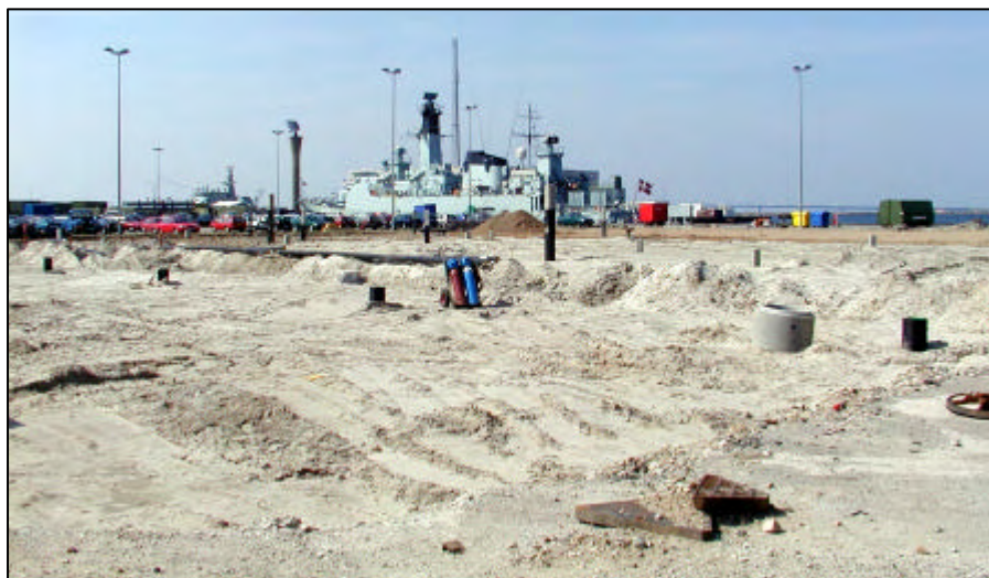
Der skal nedrammes 210 betonpæle, hver med en længde på 17 til 18 m.
