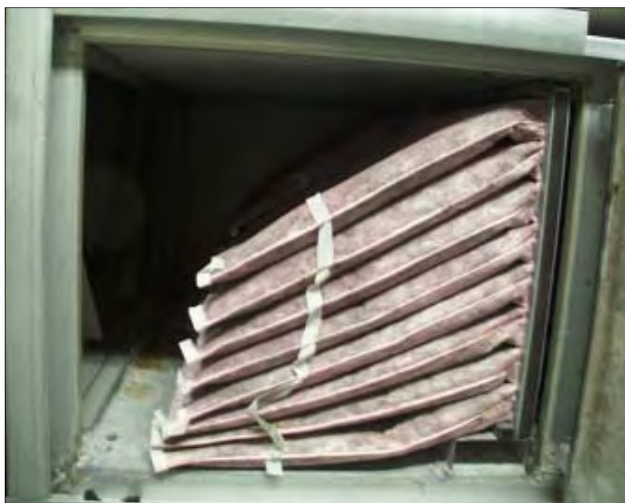
Et kig ind i en ventilationsskakt.
