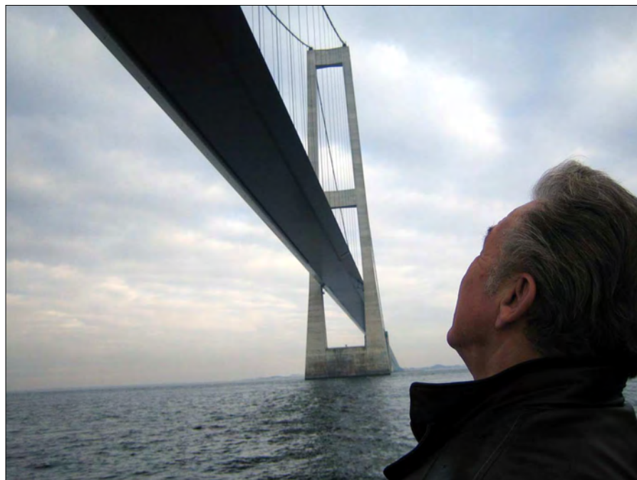
Broen er et imponerende bygningsværk, hvilket vi kunne konstatere, da vi sejlede under broen.
