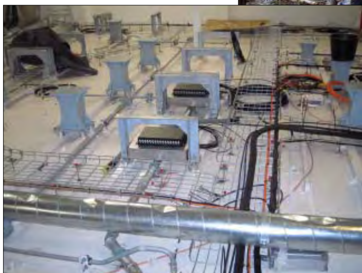
I ABSALON's O-rum foregår meget omfattende installationer til konsoller, stole og C-FLEX installationen. Foto: Steen K. Jensen.
