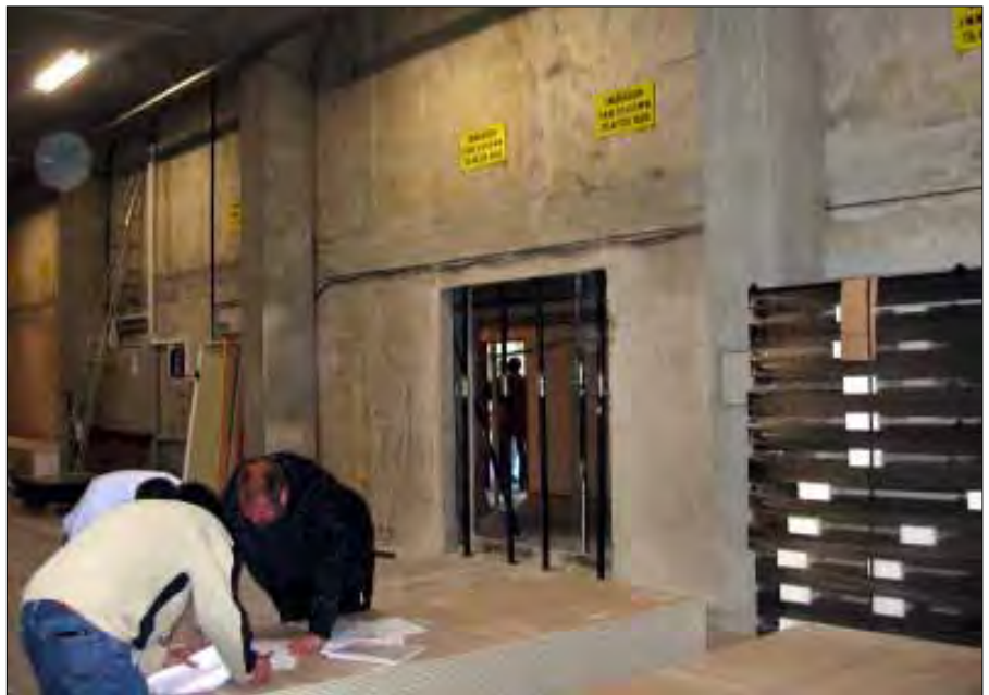
For at få direkte adgang til arkivet laves der et nyt dørhul mellem kontorer og hal.
