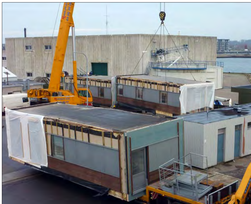
Ny pavillon til fregatprojektet i Korsør
