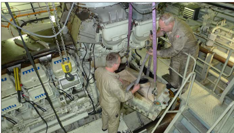
Montering af ny unit.
