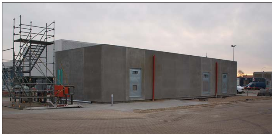
Transformerbygningen ses her under opførelse. Den blev indviet medio FEB d.å.
