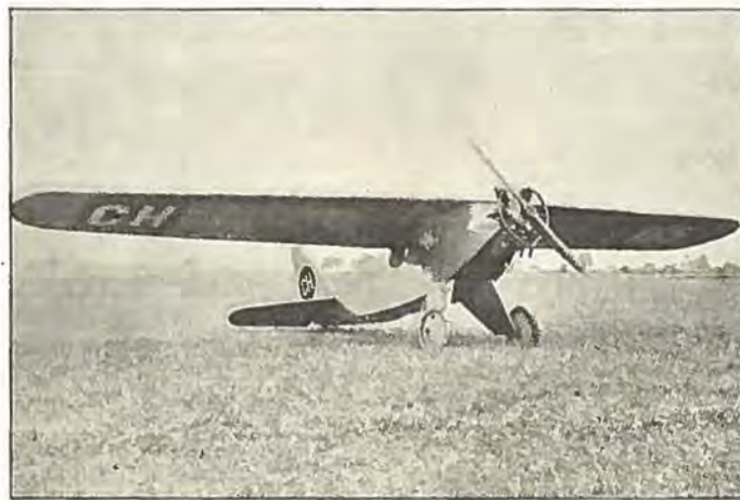
Ingeniør Schmid i Zürich har konstrueret en ny Sportsflyvemaskine. Motor: 50 HK. Anzani; Tomvægt 300 kg; Nyttelast 250 kg; største Hastighed 150 km/T.; Benzinforbrug 18 Liter i Timen.
