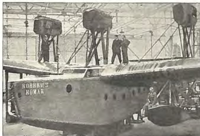
Rohrbach „Romar“ Flyvebaad til transatlantisk Traffik. Spændvidde 37 m, Længde 22 m, Højde 8,5 m, 3 Motorer af Typen B. M. V. VI med en samlet Motorstyrke paa 2160 HK. Foruden en Besætning paa 4 Mand (Fører, Navigator, Telegrafist og Mekaniker) samt 12 Passagerer kan der medføres 7900 Liter Benzin og 400 Liter Olie. Den samlede Vægt er 19 Tons og med den her nævnte Nyttelast har Maskinen en Aktionsradius paa 4000 km.
