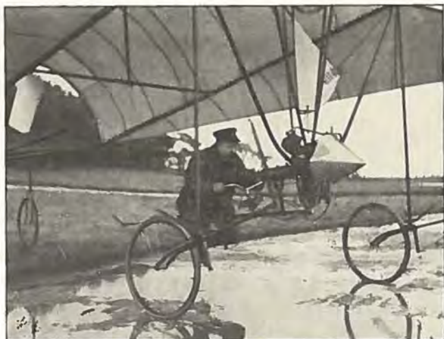
Motor og Førersæde er paa de første Maskiner anbragt i Pendulophængning.
