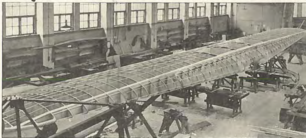
Det 23 m lange Plan til Fokker-Trafikflyvemaskinen, Type F. XVII, klar til Beklædning.
