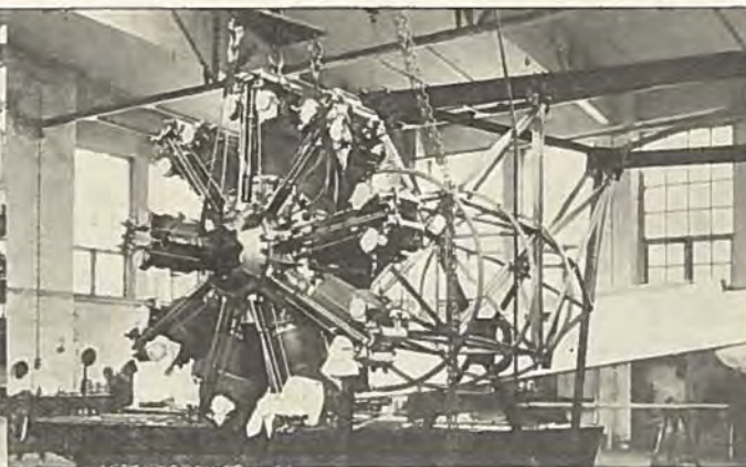
Motorgondolen til en af de to Sidemotorer. En Bristol-„Jupiter“ anbringes paa sin Plads.
