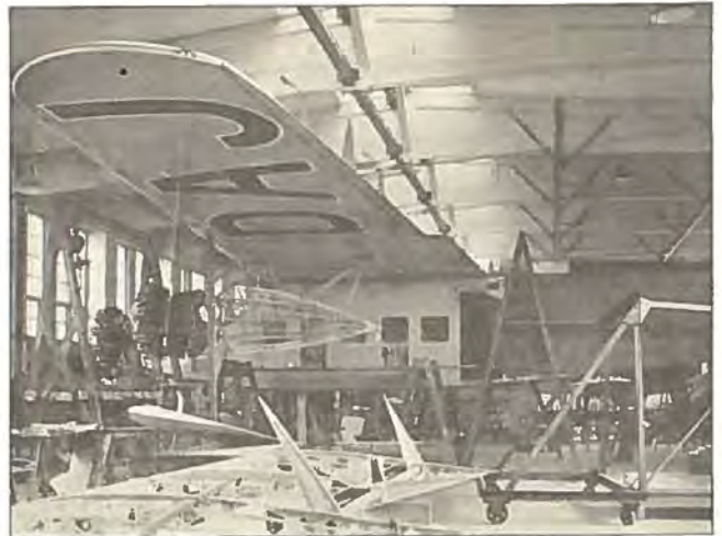
3/4 — Monteringsarbejdet er i fuld Gang.
