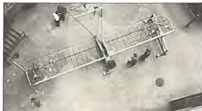
DL3 under Bygning.
