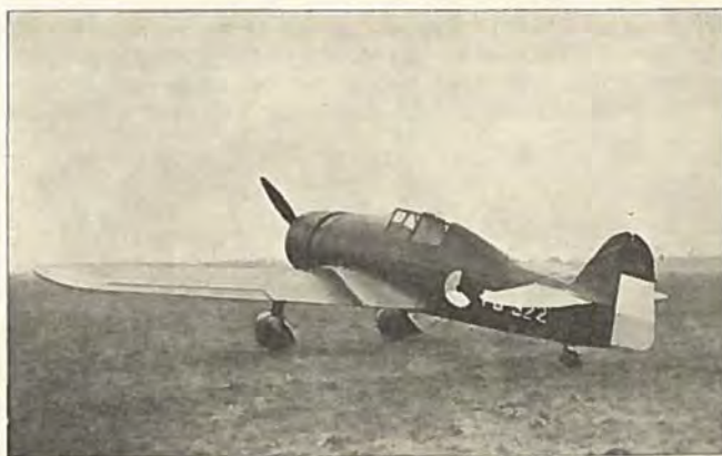
Nyeste hollandske Jager: Fokker D 21. Største Hastighed: 450 km/T. Motor: Bristol Mercury eller Hispano.
