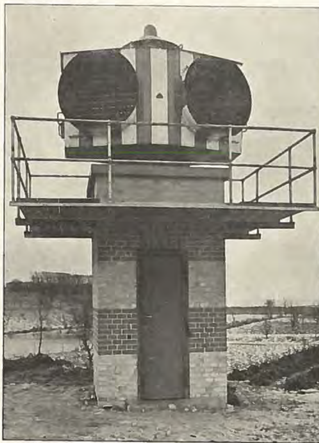
Fundamenthus med Projektør, ca. 4,5 m højt.
