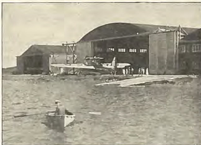
Hangar ved Cape May.
