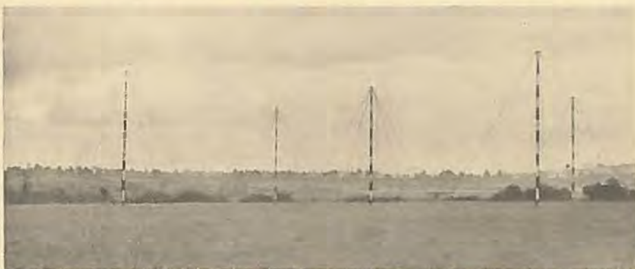
Antennesystemet der benyttes ved et Adcock-Pejlanlæg (Fabrikat: Standard).
