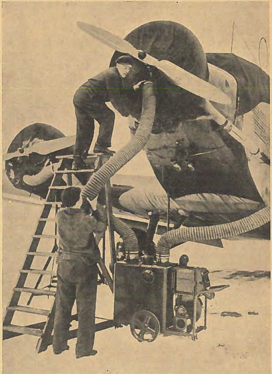
Fig. 2. En tre-motoret Ju 52 opvarmes ved Hjælp af elektrisk opvarmet Luft.
