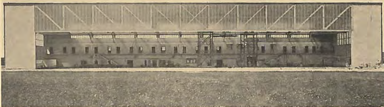
Hangar B, der har en Portaabning paa 77×9 m.
