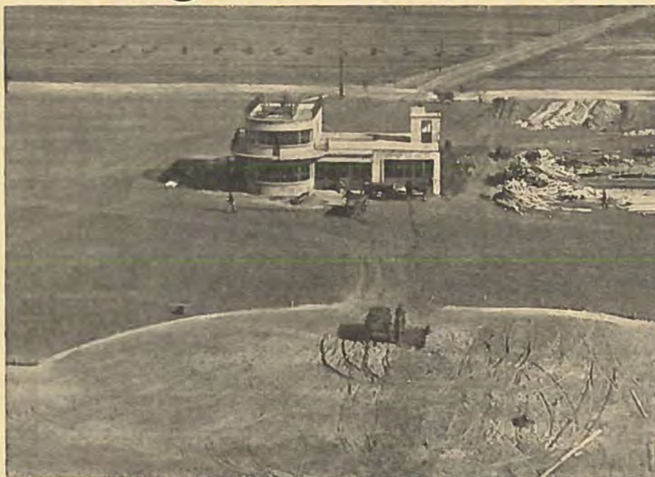
Administrationsbygningen paa Aalborg Lufthavn.
