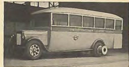
»Aviators« Omnibus med paamonteret Tromle til Spilstart.
