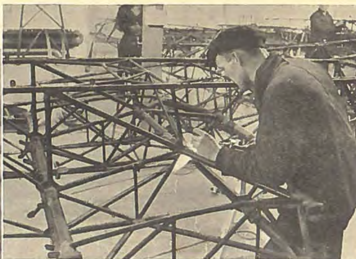
400 Sammensvejsninger kræver Flyvemaskinens Staalskelet.
