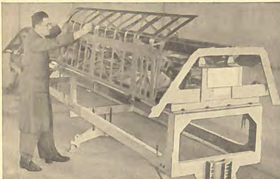
Tilpasning af Kropklapper hos Dornier.
