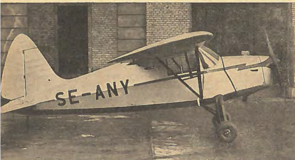
Fremtidens danske Privatmaskine: KZ III, et højtinget Monoplan med 165 Kilometer Marchhastighed, to-sædet side by side og i Stand til at starte paa 35 Meter. Den kan lande paa 30 Meter.
