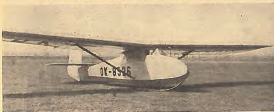
Det czekiske Overgangspan Krajánek, der modsat Grunau Baby har lige Ryg og svajet Kølister.
