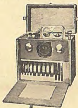
Prøveapparat for Differenstrykmaalere
