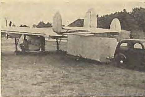
Maskinen er lige landet, Fragtrummet afmonteres og køres bort, mens Agterstykket igen sættes paa.
