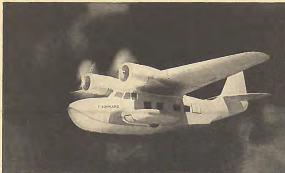
En Model af det norske Amfiblum 5A, som vi omtalte i sidste Nummer. Det er en Flyvebaad med kombineret Hjul- og Skilunderstel, som trækkes ind i Støttepontonerne.
