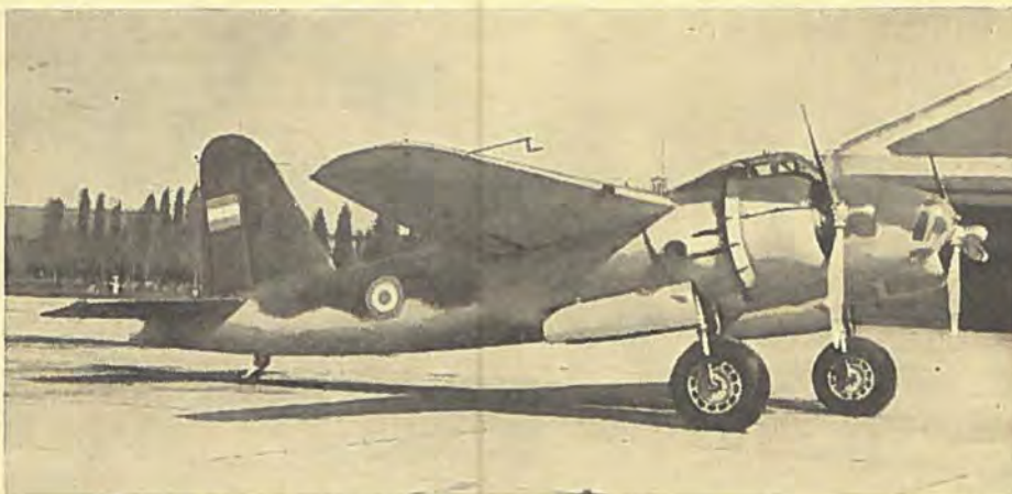
DL-24 Calquin er Argentinas lette bomber i Mosquito-klasse. Den har to 1050 hk Pratt & Whitney motorer.
