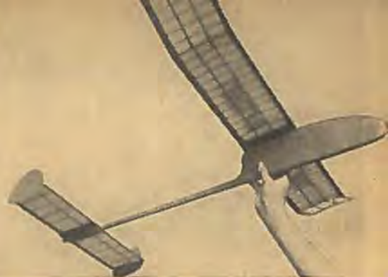
Engelsk svævemodel »Gili Hatchet« af P. Gullmant. Spv. 1 m. Denne svensk-inspirerede model er bygget for at få erfaringer til en stor model.
