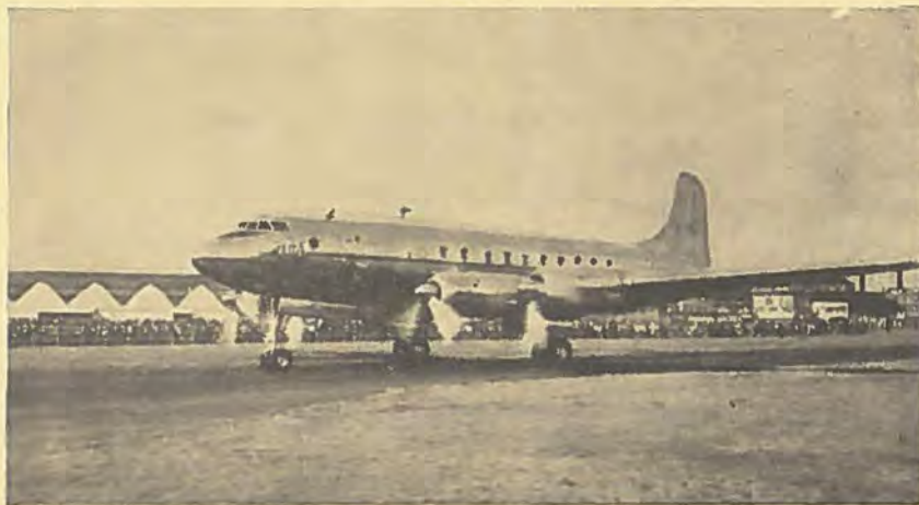
Handley Page Hermes V er den største flyvemaskine udstyret med propelturbiner.
