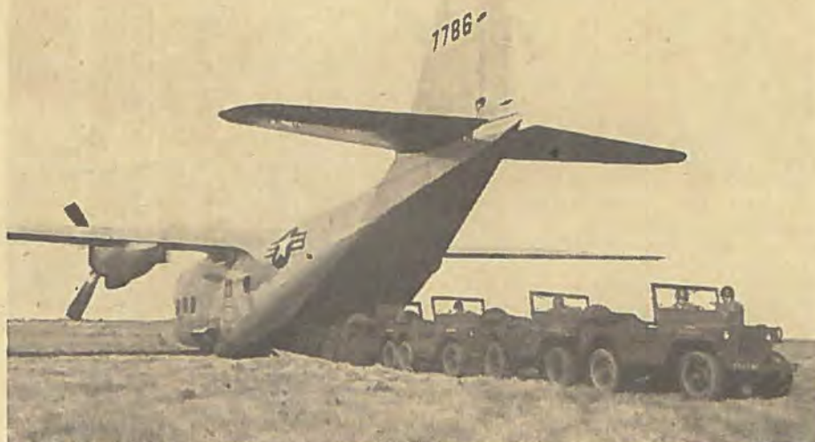
Chase XC-123 transportflyvemaskine kan anvendes som motorflyvemaskine eller glideplan og f. eks. transportere 5 jeeps.
