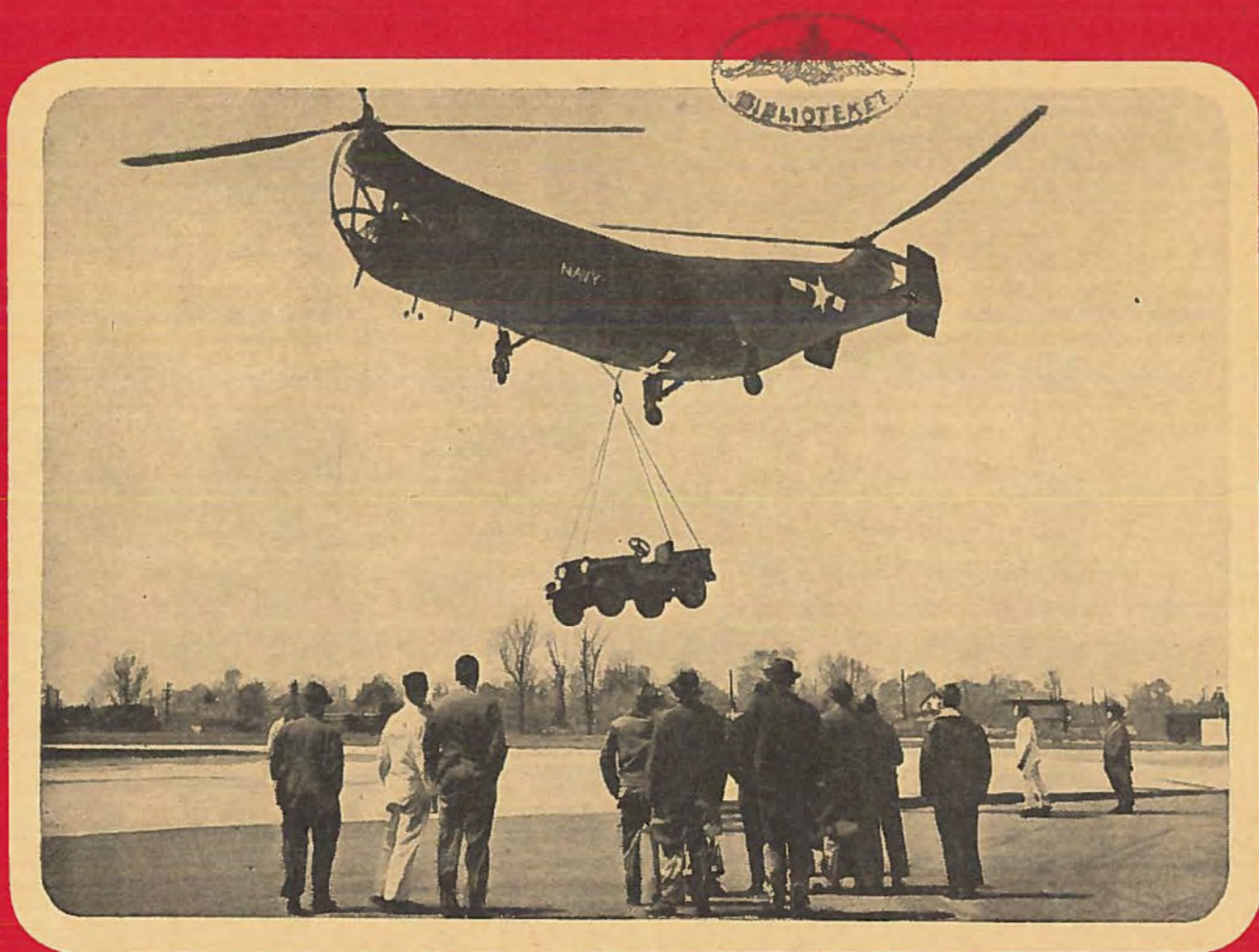
Helikopter som flyvende kran: En Piasecki XHRP-1 løfter en jeep. Helikopteren er udstyret med en 600 hk Pratt & Whitney motor.
