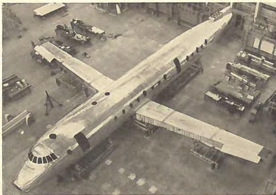
Den første prototype af Bristol 175 Britannia er under samling på Bristol-fabrikkerne i Filton og ventes at flyve hen på sommeren. Den bliver udstyret med fire Bristol Proteus turbinemotorer og kan medføre op til 104 passagerer med en fart af 585 km/t.
