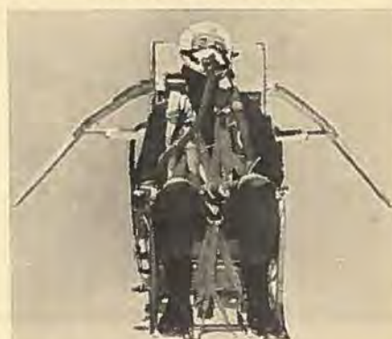
Til foregøtypen Douglas X-3 er der konstrueret et katapultsæde, der skydes ud nedad og stabiliseres af to finner. I 4,5 km højde frigøres piloten automatisk og fortsætter med pr. faldskærm.
