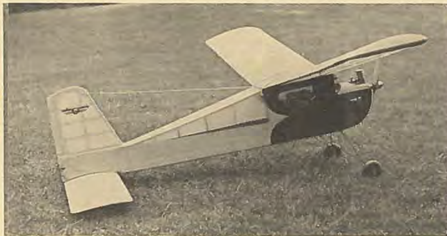
Modellen Electra som ny, med ED 2 cm 3 motor. Modtageren ophængt horisontalt i gummibånd. Sideroret er kun 90 × 15 mm.
