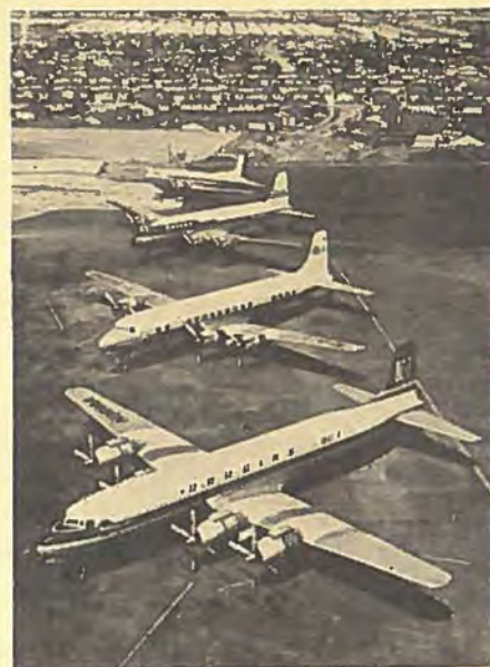
4 Douglastype: forrest DC-7, derpå DC-6, DC-4 og en Super-DC-3. DC-4, som de øvrige firemotors typer er udviklet fra, havde en fuldvægt på 28 tons, kroplængde 25,6 m, spændvidde 35,8 m.
