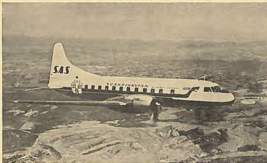
Sådan kommer Convair 440 Metropolitan til at tage sig ud i SAS-bemaling. Som man ser afviger den udadtil ikke meget fra 340 (se iverigt side 209). Tegningen nederst på siden viser, at man ved at sløjfe et fragtrum fortil har fået plads til 8 passagerer mere end i 340.
