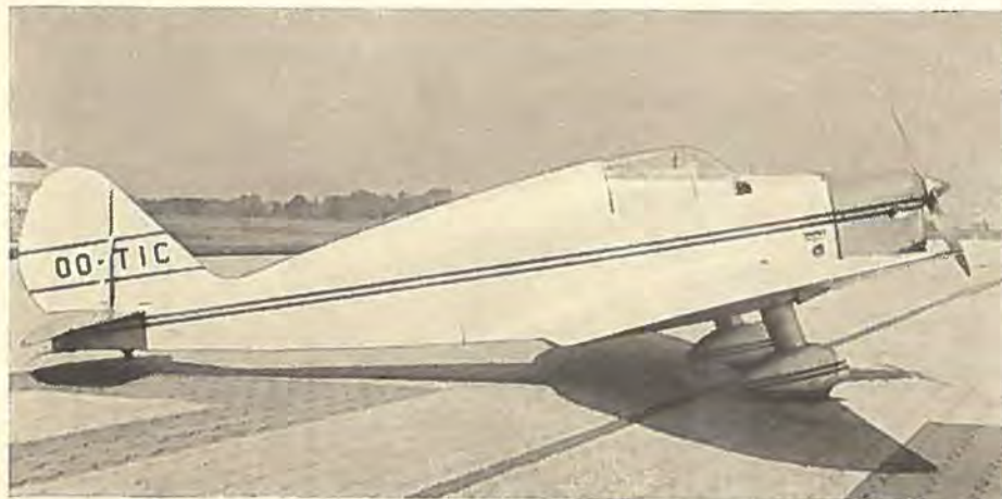
Den lille Topsy Belfair, som rekordflyvningen blev udført i. Den er normalt udstyret med to sæder side ved side. Motoren er en 62 hk Walter Mikron. Den er bygget af træ. Spændvidde 9,5 m, længde 6,6 m, højde 1,7 m, planareal 12 m 2 . Tomvægt 245 kg, fuldvægt 500 kg. Topfart 177, rejsefart 160, stallingfart 60 km/t. Normal rækkevidde 750 km.
