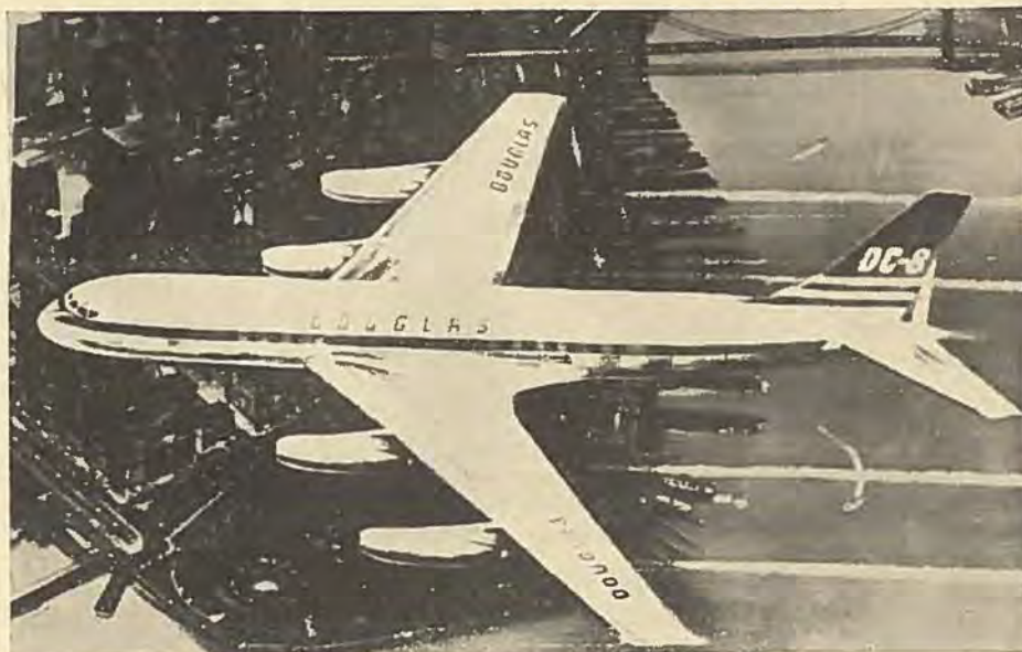
En tegning af den kommende DC-8. Amerikanerne holder sig stadig til den udvendige anbringelse af motorene.
