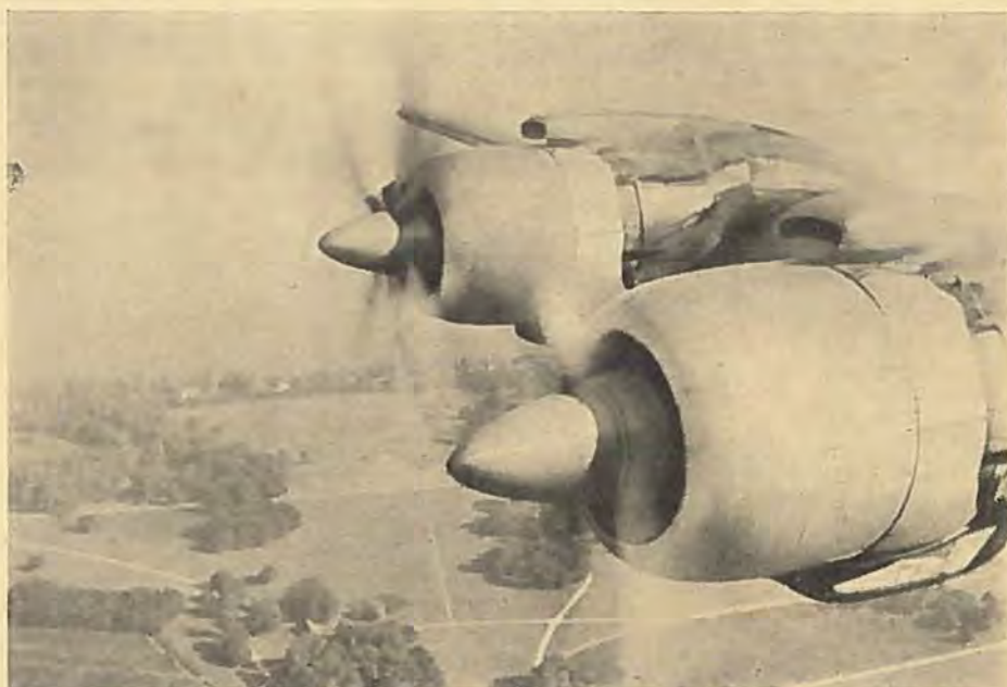
Udsigt fra forreste passagersæde mod to af Wright Turbo Compound motorerne, mens »Brage Viking« med 470 km/t i lav højde flyver over Dyrehaven.
