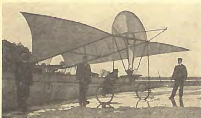
Ellehammers flyvemaskine i 1905, der ikke kom i luften. Heraf udviklede han 1906-modellen på forsiden.
