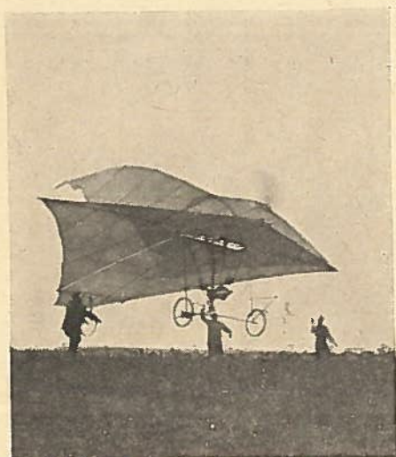
For at prøve flyvemaskinen foretog Ellehammer og hans medhjælpere hævningforsøg som vist her. Uden pilot kunne den med motoren løbende holde sig svævende ved en vind på 17 msek.
