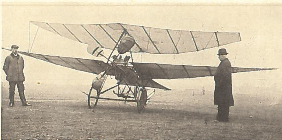
Så blev mellemplanet fjernet, og her har vi 1908-biplanet, hvormed Ellehammer fløj i Kiel.
