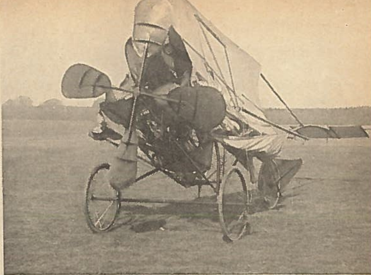
Også 1908-biplanet kunne klappes sammen efter denne metode og var på denne måde forholdsvis let at transportere til flyvestævnet i Kiel.
