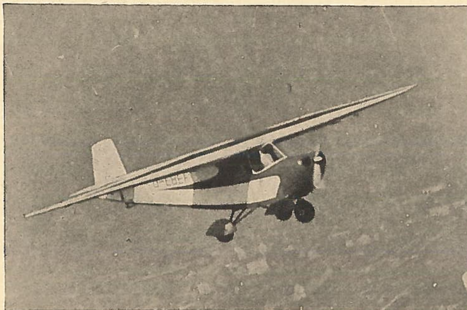
HD-153 Motor-Möve er en velformet moderne privatflyvemaskine til to personer. Den drives af en 65 eller 85 hk Continentalmotor.
