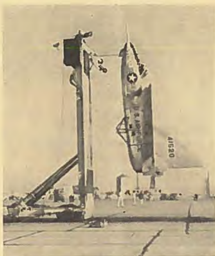
Ryan X-13 Vertijet kan starte fra dette stativ, overgå til vandret flyvning og tilbage igen til lodret, hvor den blandes ved at hægte sig på stativet.
