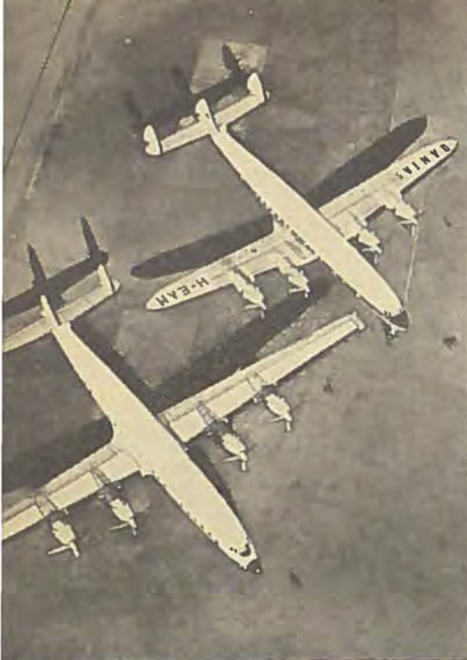
Lockheed 1649A Super Constellation er formodentlig den sidste langdistancetype med stempelmotorer. Med en spændvidde på 45,5 m er den over 8 m større end 1049 H Super Constellation ved siden af. Rækkevidden er op til 10.000 km.
