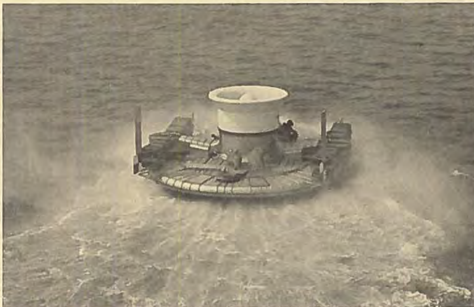
Saunders-Roe S.R.N.1 Hovercraft, der her ses på vej over Kanalen, var årets sensation. Motoren suger luft ind fra oven og presser den gennem en ringformet åbning fra yderkanterne ind mod midten af undersiden. Der dannes herved en »luftpude«, som den glider på.
