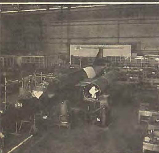
Bristol-Siddeley BE-53 med 4 udstødsåbninger, der kan drejes.
