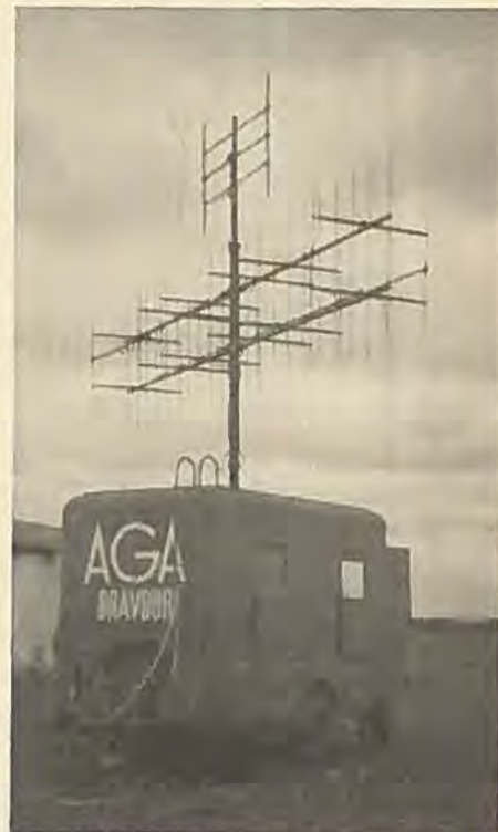
AGA-fyret med den roterende antenne opstillet i Skovlunde - prøv det næste gang, De flyver!
