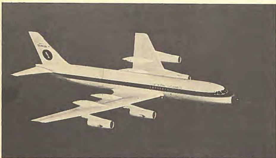
Convair 990 Coronado var i luften for første gang den 24. januar og ventes at opnå sit luftdygtighedsbevis så hurtigt, at SAS og Swissair kan få sine i brug allerede i år. Med rejsehastigheder helt op til 1030 km/t. ventes den at blive verdens hurtigste trafikfly.
