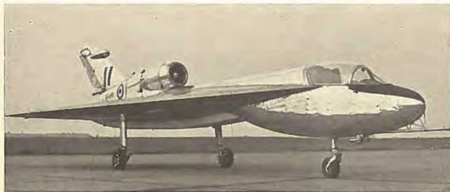
Handley Page HP 115 repræsenterede sammen med Beagle-serien de eneste helt nye typer. HP 115 er et foregødsfly til at udforske kommende overlydsstrafikflys vingeform under langsom flyvning. Derfor det faste understel.
