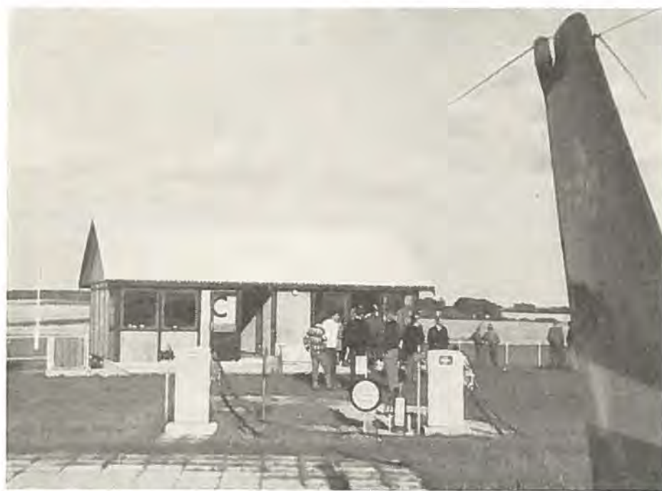
På Tune flyveplads har Morian Hansen fået bygget en nydelig lille administrationsbygning med kontor, venteværelse, køkken etc. Hangaren er også under udvidelse.
