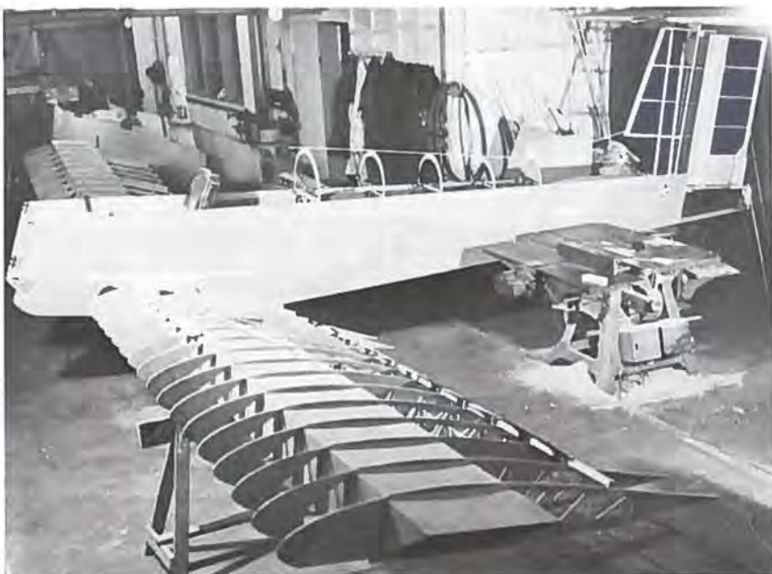
PFG's Polyt V slæbefly begynder at tage form. Flystellet ventes færdig om et par måneder, men installation af den 200 hk Lycoming IO-360-A2A motor og færdiggørelse ventes at tage et halvt år mere.
