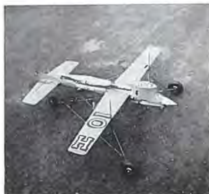
Toth's vindermodel, der opnåede 257 km/t. Bemærk effekt-lydpotten.
