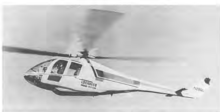
Med denne Lockheed 286 med stiv rotor blev der udført loop, rulning, styrtduk og rygflyvning ved et flyvestævne i Californien for nylig. Det er første gang, sådanne manøvrer er udført med en helikopter.
