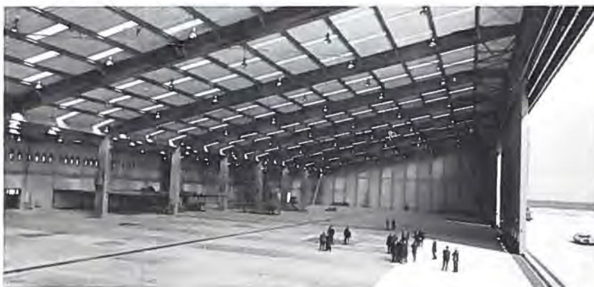
Den kæmpemæssige nye hangar 4 i Kastrup klar til at blive taget i brug. Rummet er 68×157 meter.
