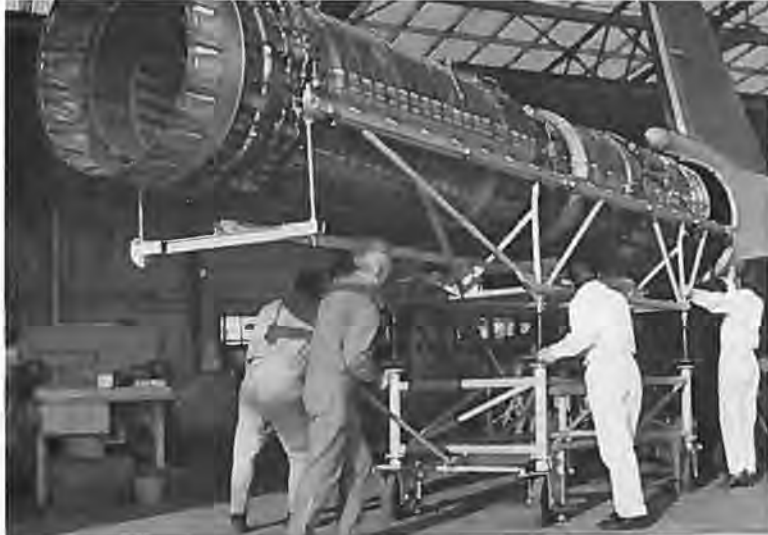
En ATAR 09K installeres i Super-Mirage F 1.
