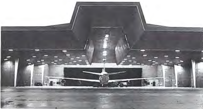
Den kæmpestore bygning til afprøvning af jetmotorer, uden at naboerne generes alt for meget. Det er en Boeing 707, der står derinde.
