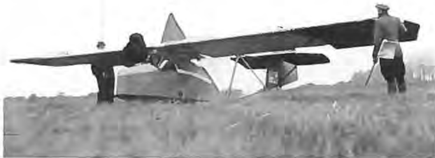
For SG-38 satte sig igennem, brugte man skoleglidere som denne Stamper & Lippisch, som endda er forsynet med „båd“, så piloten ikke sad helt ude i det fri.
