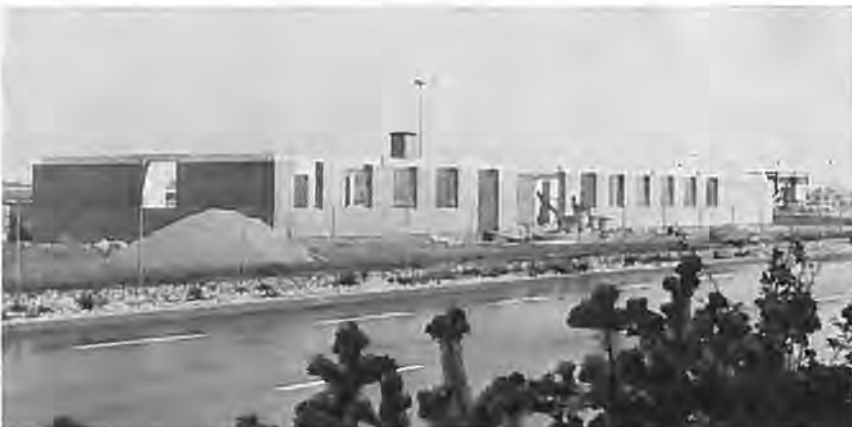
KDA's nye kontorbygning i Københavns lufthavn, Roskilde, fotograferet den 16. august, kort før dør kom tag på. Der var rejsegilde 12. september.
