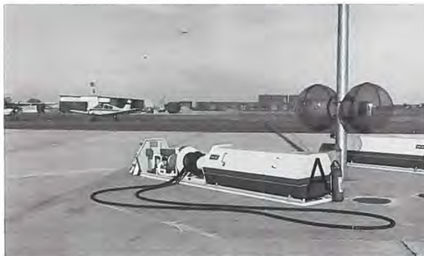
Med Roskildes nye hangarer i baggrunden ses her hydrantselskabets hyper-moderne tankningsanlæg, der drives af BP og Shell. Det er beregnet til selvbetjening, men er foreløbig bemannet trods den ringe trafik. Prisen er 3½ øre mere end andre steder.
