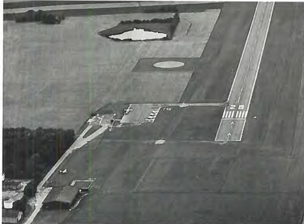
Maribo set fra øst med nogle af Højbygårds bygninger og hangaren nederst til venstre. Den nye bygning skimtes ved platformen og bag denne springgraven. Asfaltbanen er 980 m lang. Til højre for den holder svæveflyverne til.
