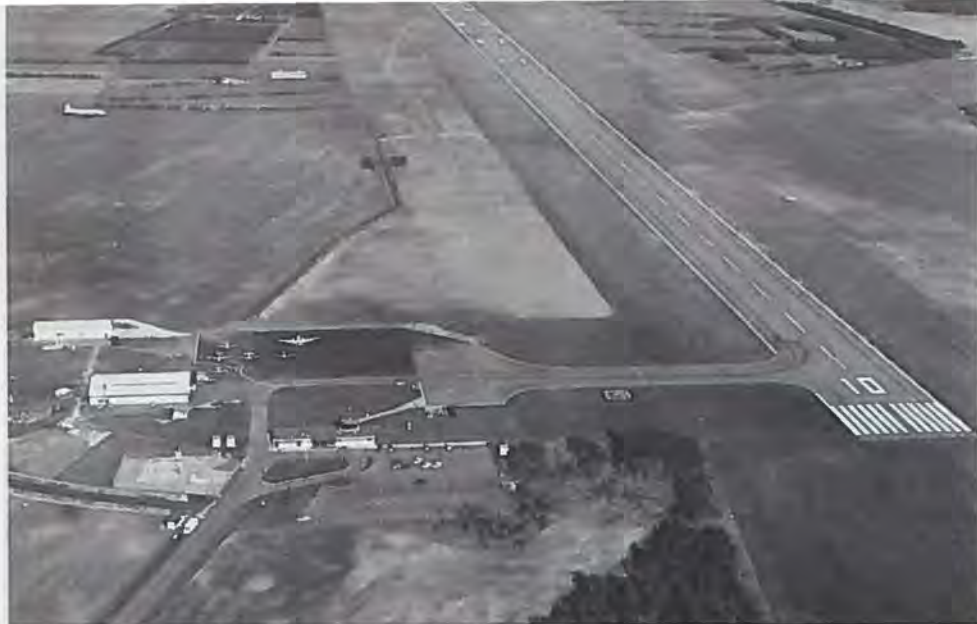
Thisted lufthavn set fra vest med udvidet startbane og platform, terminalbygning og hangar m.m. DC-7'en overst til venstre er ikke på vej ind over pladsen, men står parkeret på en mark på ubestemt tid.
