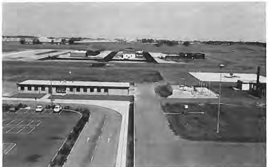
Et antal nye fine hangarer er skudt op i Roskilde og har afhjulpot hangarmangelen i havnen. Der er byggemodnet yderligere plads til hangarer vest for de nuværende. Foran ses KDA's hus, som alle passerer, inden de kører ind på parkeringspladsen. Avia Radio bor nu også i huset.
