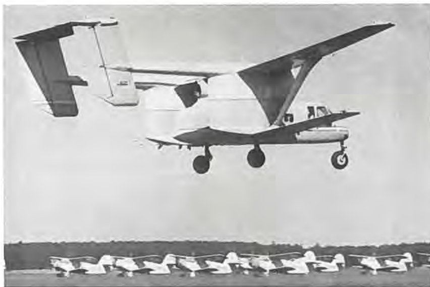
Den polsk-russiske Mielec M-15 er et interessant jetdrevet landbrugsfly til afløsning eller suppler- ring af Antonov AN-2, som der ses en række af under flyet.
