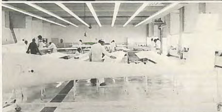
Øverst er en krop med halefinne ved at blive bygget. I midten »trikotagefabrikken«, hvor der trækkes glasfiber-rovings til hovedbjælker, og nederst et indtryk af det arbejdskrævende slibearbejde, der stadig er nødvendigt for at få overfladerne perfekte.
