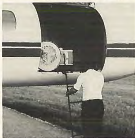
Bagtil har Metro II en dør på 1,35 x 1,30 m og der er plads til godt 5 m 3 bagage i den normale 19 passagers udgave.
