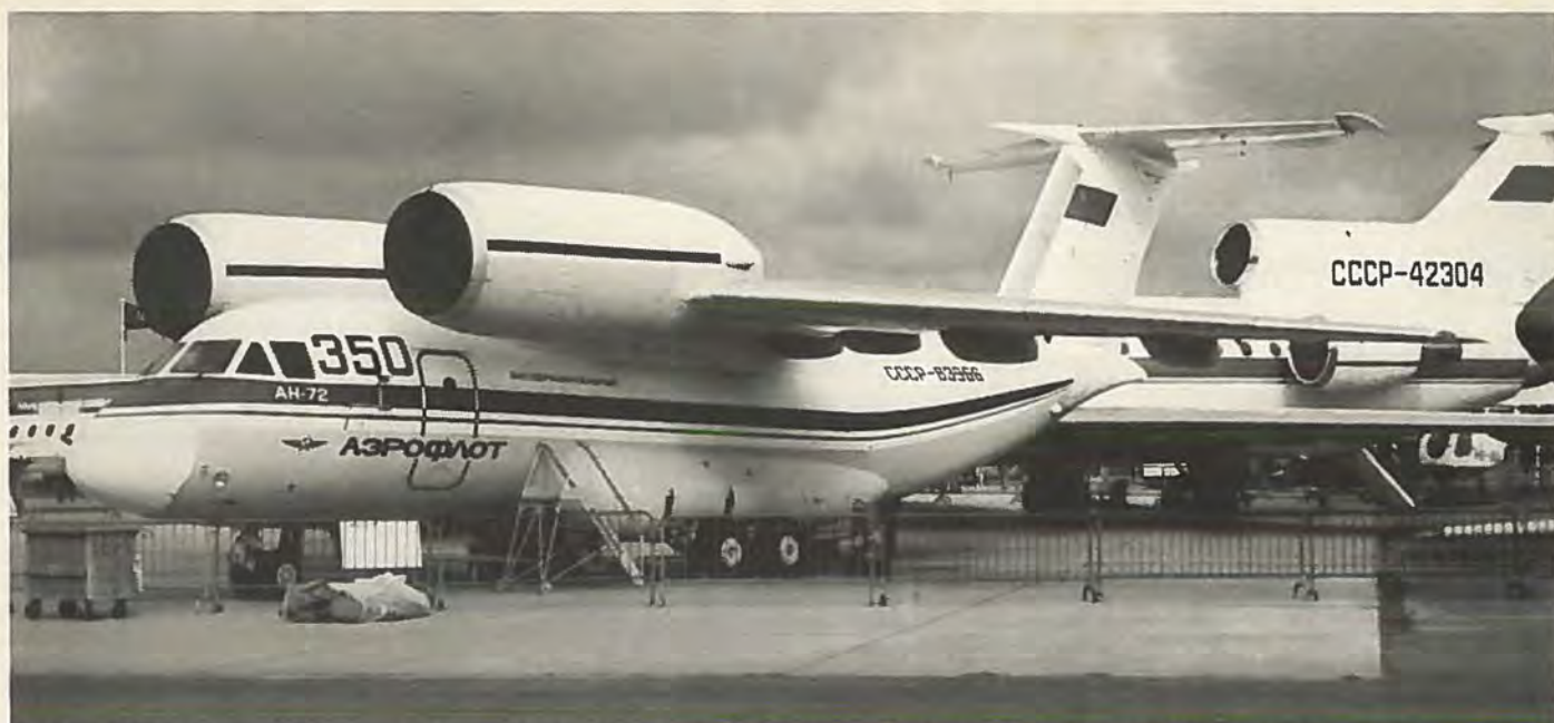
Antonov AN-72 prototypen minder om Boeing YC-14, men har ikke som den blæste flaps. Motorerne er anbragt højt for at undgå ind sugning af fremmedlegemer.
