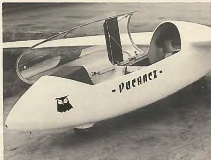
Den tosædede Puchacz har i bagsædet instrumentbrættet i førerskærmen.
