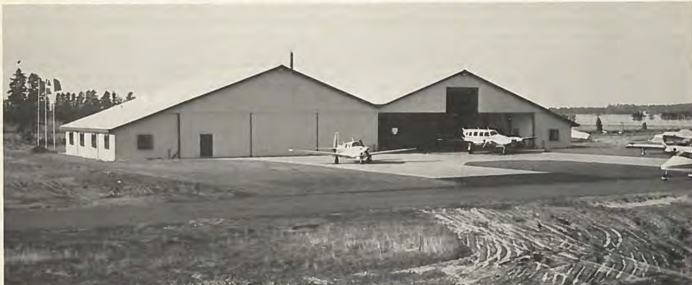
Sun-Air's bygning i Billund set fra østsiden. I venstre side ligger kontorerne mod syd, i højre lager m.m. Bemærk den ekstra lem i hver hangarmidte til fly med høje halefinner.
