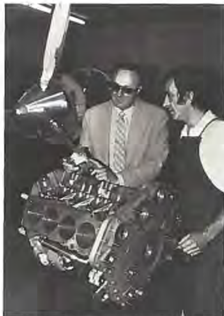
R. P. MacCoon (tv) inspicerer en aluminiums-cylinder af Reynolds 390 legeringen, der gør det muligt at lade stemplet løbe direkte i cylinderen uden støbejerns-foring.
