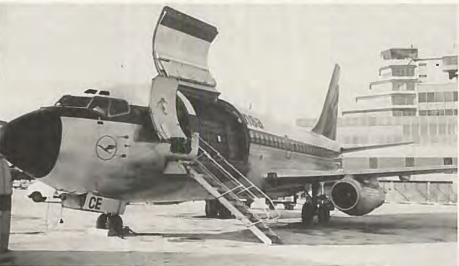
Lufthansas Boeing 737F har en ordentlig luge til lastning og losning af fragt.
