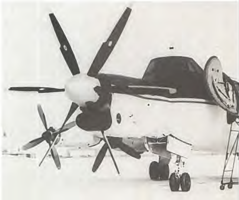
Denne 5-motorers Viscount bruges til afprøvning af en ny 6-bladet propel, udviklet af British Aerospace og United Technologies Hamilton Standard til BAe's ATP trafikfly. Den er mere lydløs og mere brændstofbesparende end tidligere.
