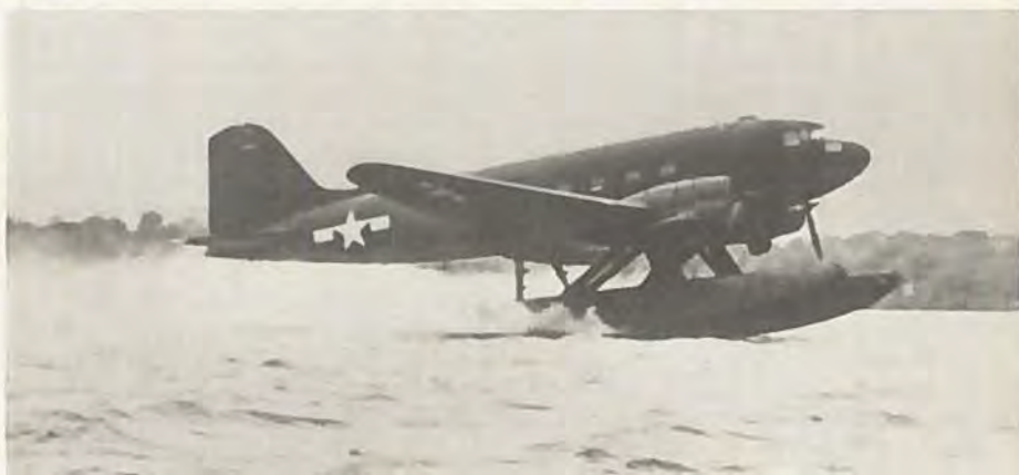
DC-3 eller C-47 er også brugt som søfly med de største pontoner i flyvningens historie - over 12 m lange.
