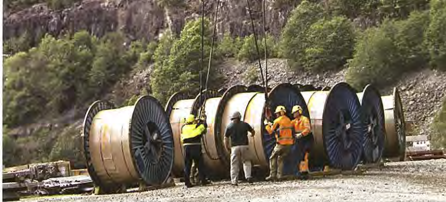
Jordpersonellet skal arbejde hurtigt, og vide hvad de gør, ellers bliver omkostningerne for høje, da Camille brænder en liter brændstof af hver andet sekund! Erickson-tekniker Frank Grooms leder arbejdet.
