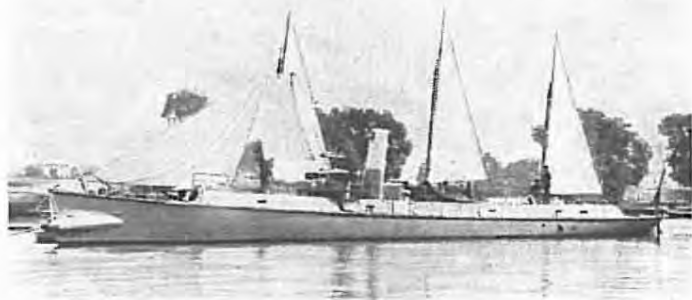
Torpedobaaden DELFINEN (TT 9 — 1883) rigget med master og sejl til overfarten fra England til Danmark. Let udfaldende stævn med fremspringende og lavtsiddende stævnror, der beskyttedes af en jernbojle. Da lokomotivkedlen omkring aarhundredeskiftet erstattedes af to mindre vandrørskedler, fik baaden to tynde skorstene.
