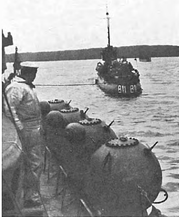
Torpedobaad af SPRINGEREN-klassen med miner paa vippe-apparater langs skibssiden (1923). I baggrunden SÆLEN (B 11).
