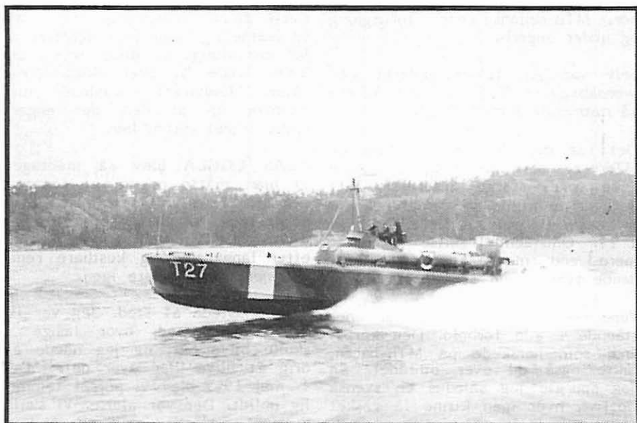
Svenskbygget motortorpedobåd T 27. Fartøjet var bygget af stål, deplacerede 27 t, og de 1060 HK kunne give det en fart på næsten 50 kn.
