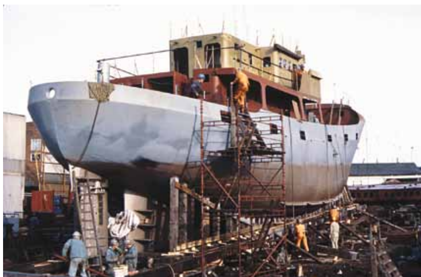
En orlogskutter af AGDLEK-klassen under bygning på Svendborg værft 1972-78.
