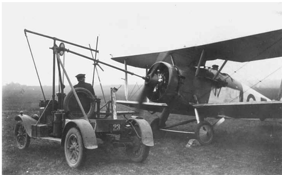
Luftmarinestationen i Ringsted var i besiddelse af et mobilt teknisk hjælpemiddel til at starte jagermaskinernes motorer. Her ses en Hucks startemaskine, der blev koblet direkte til propellerakslen og tvang motoren rundt til start. Her ses
