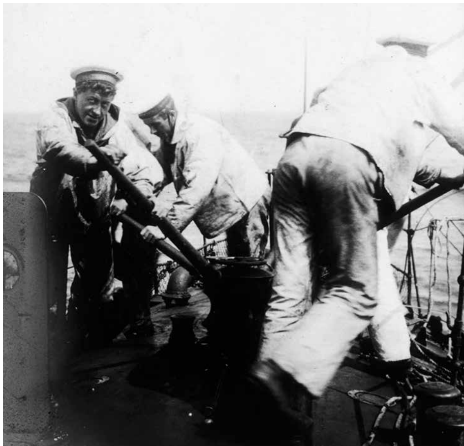
Ankeret indhales. Der skulle lægges kræfter i, da det foregik ved hjælp af håndspager isat spillet og så rå muskelkraft. (O. H. Quade / Forsvarsgalleriet)
