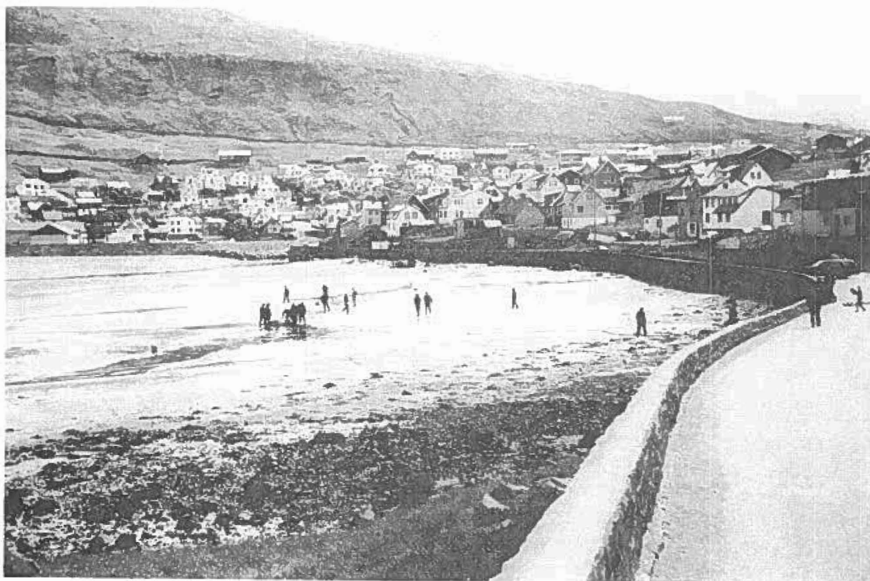
Fra oprensningsarbejdet i Sørvaag
