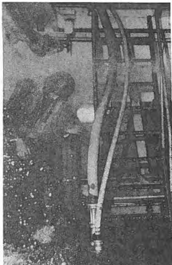
Lænsning med ejektor. (SVN FOT).
