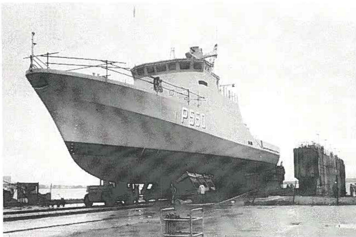
Nybygning 253 under indrangering i flydedokken. (SVN FOT).
