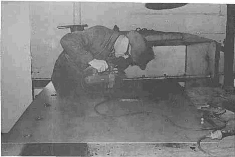
Udskæring af stålpladerne. (SVN FOT).
