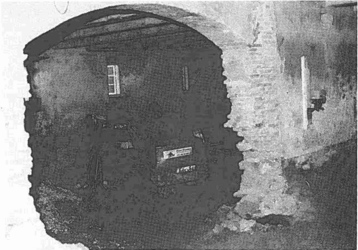
Udgravningen af kælderetagen. (Orlogsmuseet FOT).
